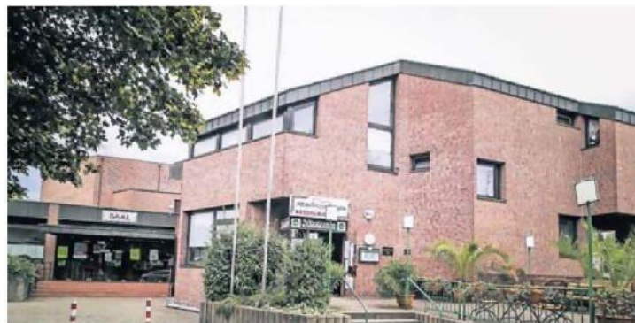
Einig sind sich alle Fraktionen, dass die Albert-Mooren-Halle unbedingt erhalten bleiben muss. Die notwendige Sanierung ist aber eine teure Angelegenheit.
