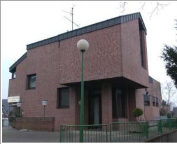
Das Dach der Albert-Mooren-Halle soll saniert werden – da sind sich alle Fraktionen einig.
